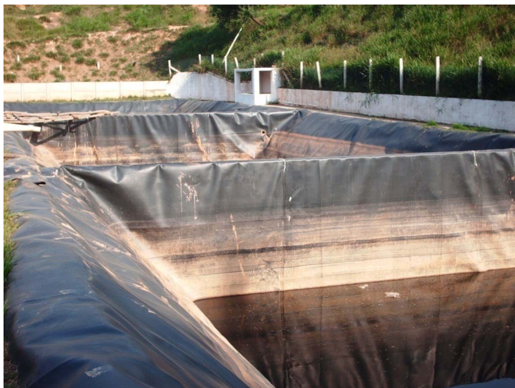
Lagoa Coletor de lixiviado aterro Tecipar
